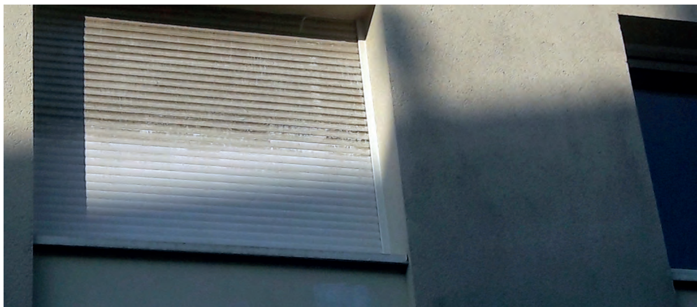
Essai de nettoyage au SOLUNOVAL sur volet roulant en PVC
