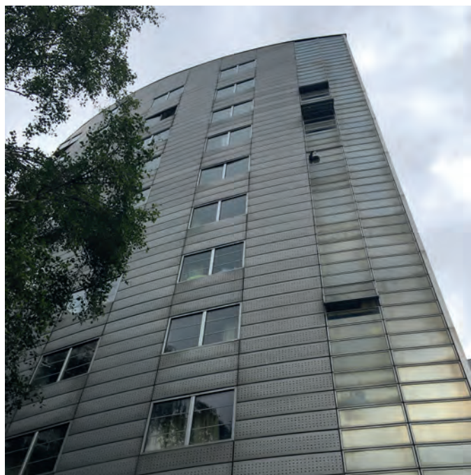
Nettoyage d'un immeuble en mur de rideaux d'aluminium.
