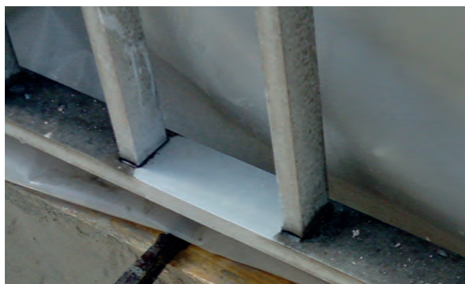
Essai de nettoyage au SOLUNOVAL sur garde-corps en aluminium anodisé.
