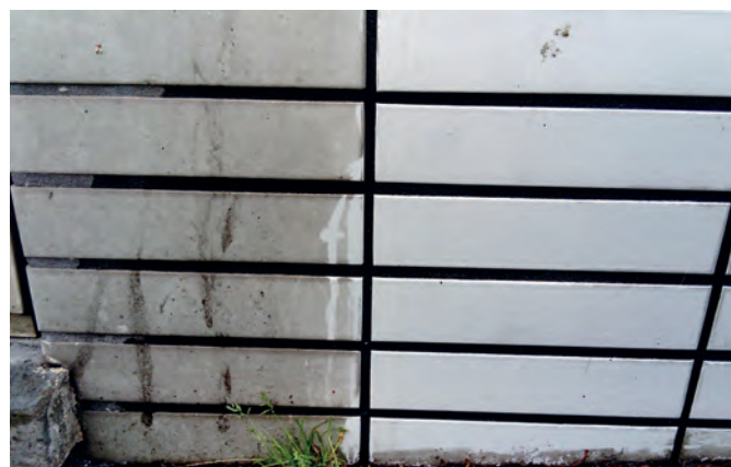
Essai de nettoyage de céramique PV3000
