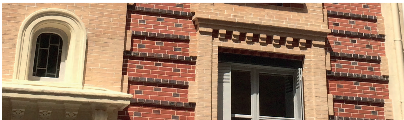
Façade constituée de différentes sortes de briques nettoyée au SOLUBRIC
