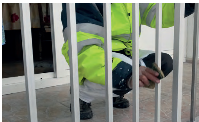
Essai de nettoyage au DG1004 sur garde-corps en aluminium anodisé.
