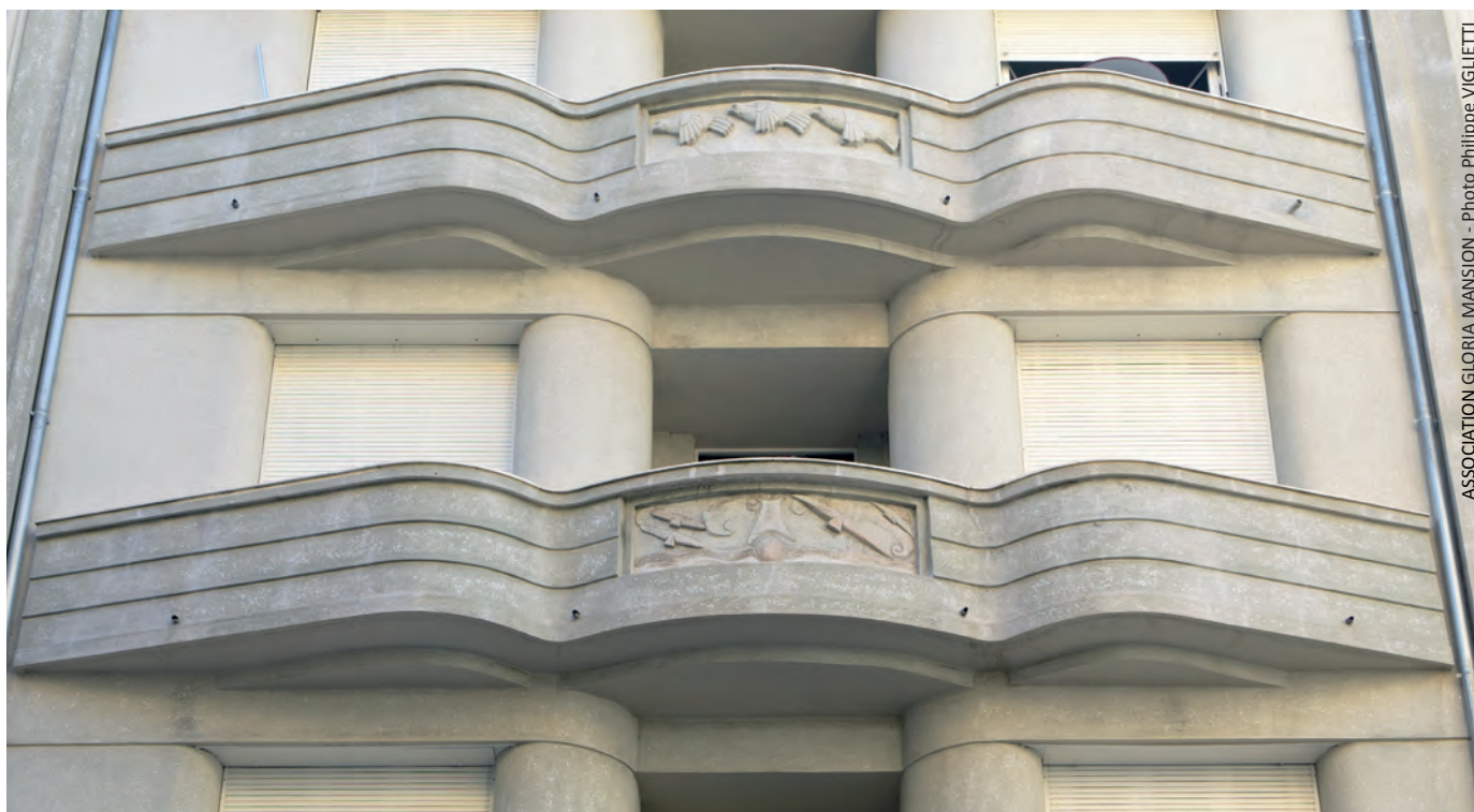
Façade en « béton coloré niçois » nettoyée au SOLUROC
