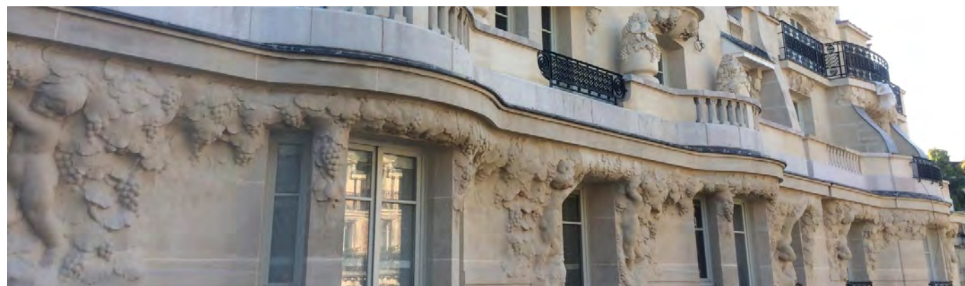
Façade nettoyée au SOLUROC + OXIPHYCEE
