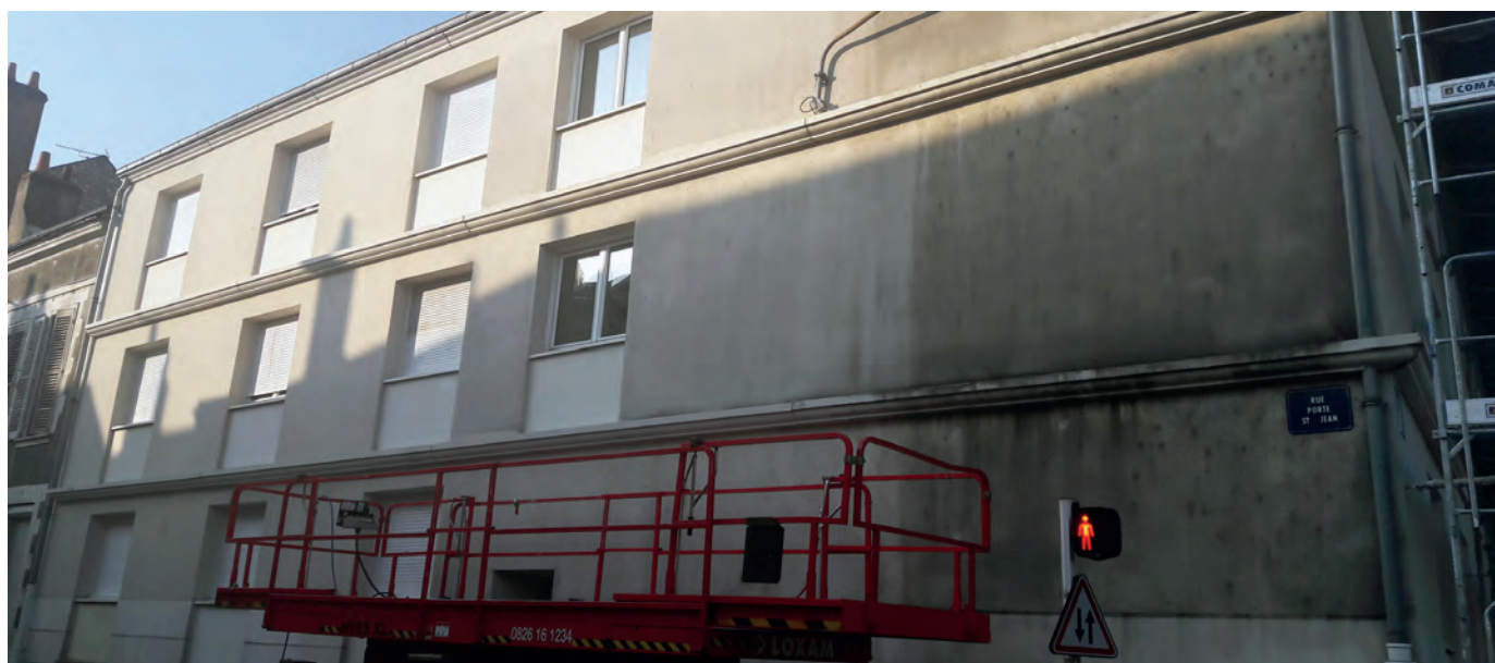
Façade en enduit nettoyée au NS96 (Dilution à 1 volume pour 3 volumes d'eau)
