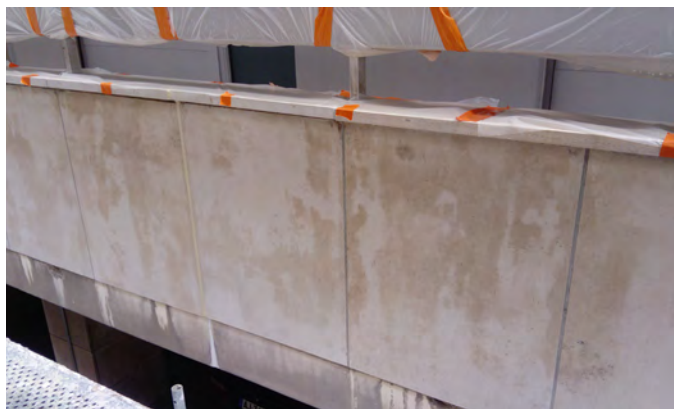
Après nettoyage au SOLUMAX (pollution urbaine éliminée)
