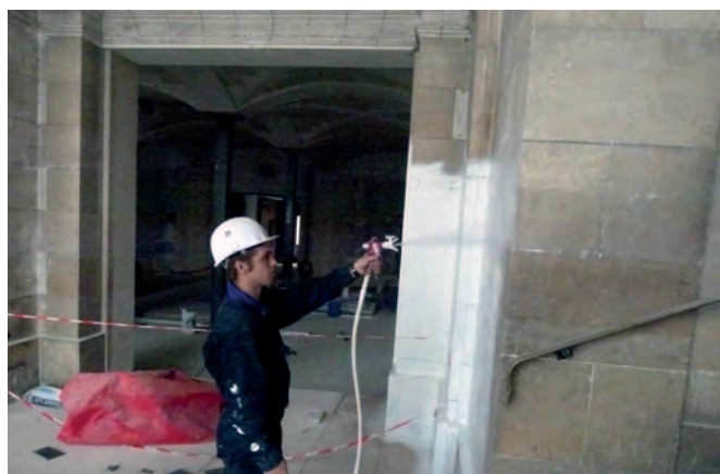
Application du SCARABEO au pistolet Air'less
