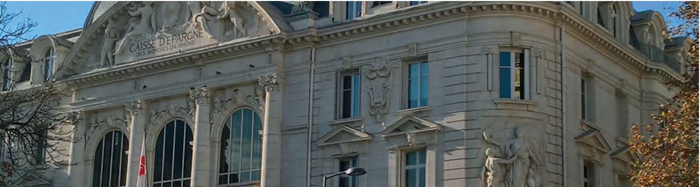
Façade nettoyée au SOLUMAX
