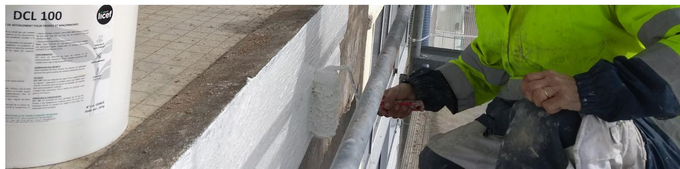
Pour traiter la présence de sels, LICEF propose plusieurs solutions, ceci en fonctions des supports et de la concentration des sels solubles présents. Il conviendra dans tous les cas, de commencer par purger les surfaces par un broissage à sec. Si la présence des sels n'est que superficielle (efflorescences de sels), appliquer notre produit **SOLUROC** puis rincer rapidement au nettoyeur HP, sans saturation excessive en eau.
